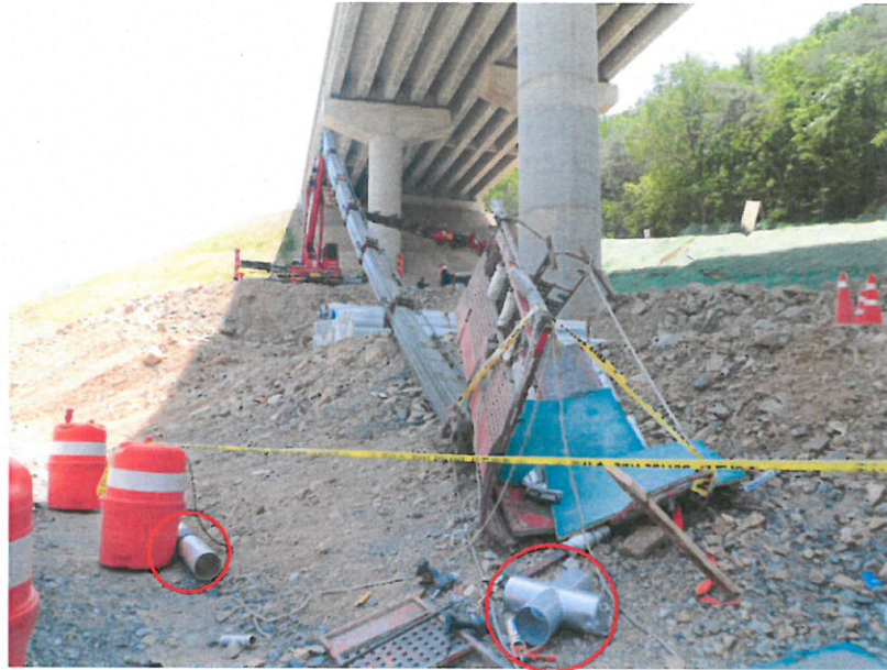
지면 바닥에 떨어진 탑승함 모습 (주변에 십자배수관 및 상부배수관이 보임)
