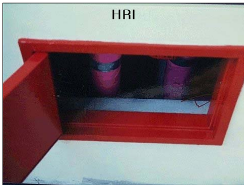
[그림16] 수직 PD의 점검시설 설치와 계량시설설치
