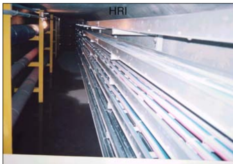
[그림10] 공동구 및 지하주차장내 트레이 및 케이블
