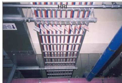
[그림10] 공동구 및 지하주차장내 트레이 및 케이블
