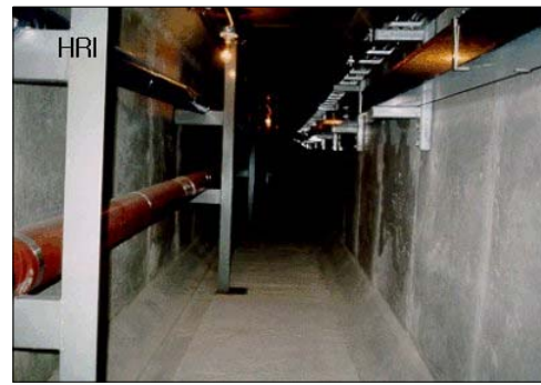
[그림11] 단지내 지하공동구 시설(좌)과 지하공동구내부 배관설치
