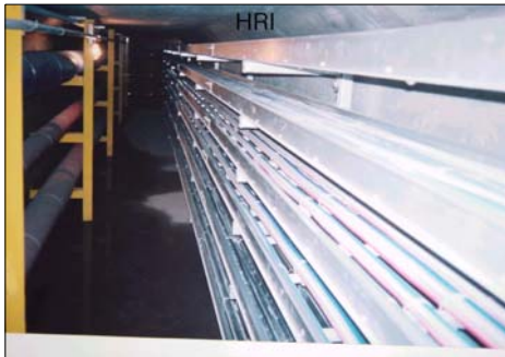
[그림29] 공동구내 트레이 및 케이블
