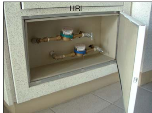
[그림16] 수직 PD의 점검시설 설치와 계량시설설치
