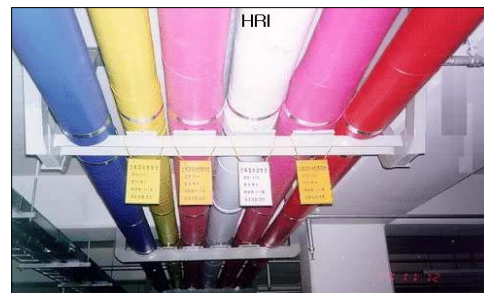
[그림13] 주동과 지하공동구 접속부(좌)와 상부에 배관설치(우)
