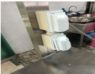
그림 530-15 설치 예시(방적형 콘센트, 건조기 배선)
