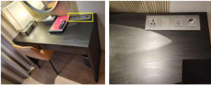
그림 530-10 가구류의 배선설비 예시
