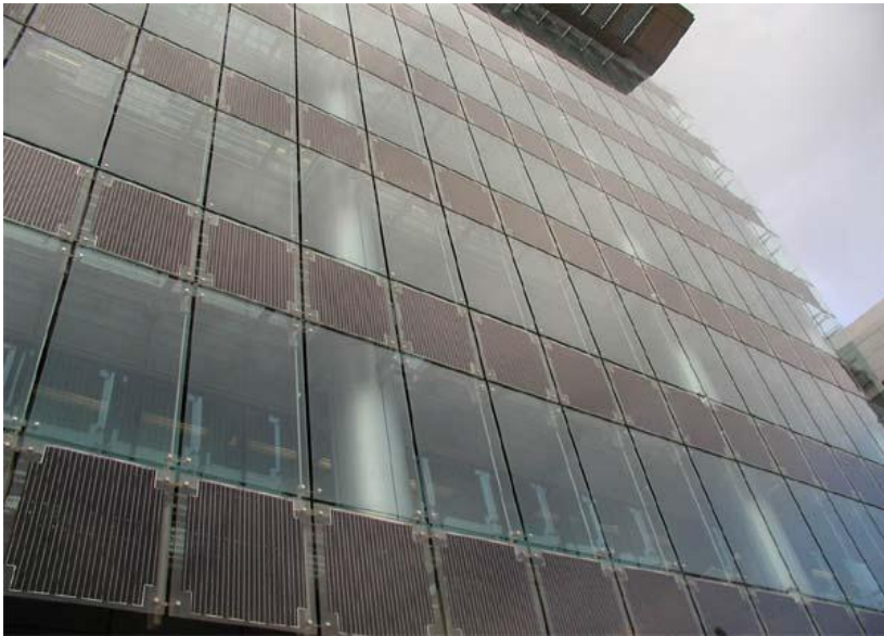
< Science Park 내 건물 외벽의 Solar Cell Array >
