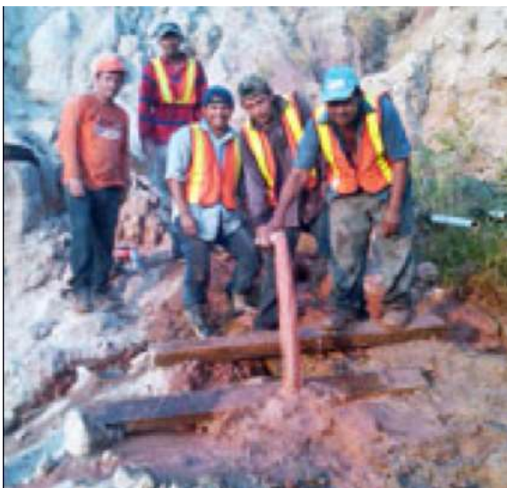
사진 4.3: 도로 활동사면에서 배수된 지하수
