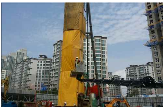
<그림 7> 항타 또는 보링시 방음·방진커버 설치
