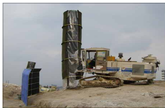
<그림 7> 항타 또는 보링시 방음·방진커버 설치
