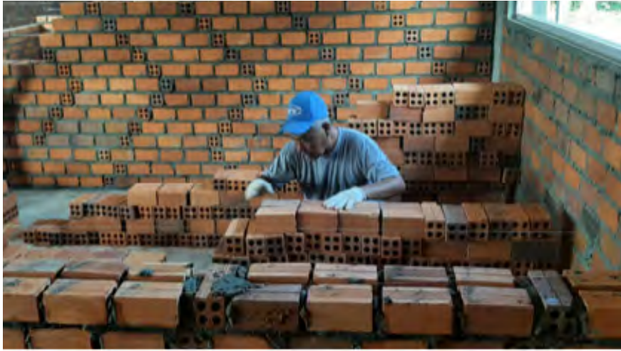
그림 2. 기존 벽돌의 시공 모습 (수평을 하나하나 맞추기 위해 작업 속도가 더디며, 벽돌 교차가 어려움)
