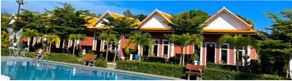
그림 4. 리조트 시공, 캄보디아
