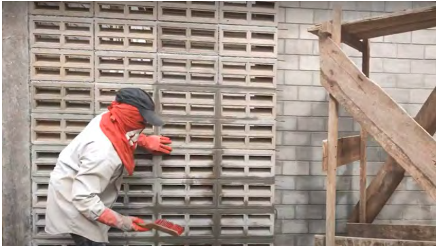
그림 3. MDH 벽돌의 시공 모습 (벽돌의 조립 방식으로 작업 효율성이 향상되고 쉽게 집을 지을 수 있어 인건비가 절감됨)
