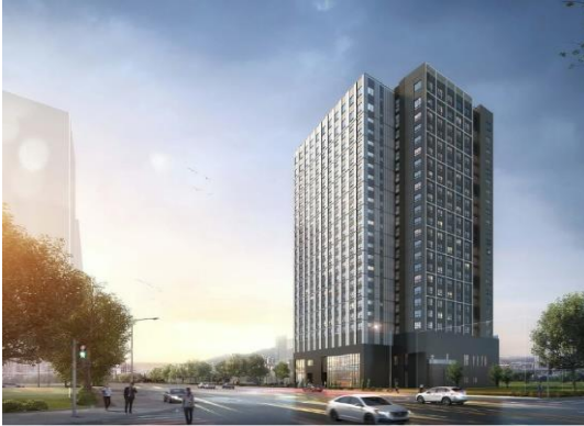
남춘천역 코아루 웰라움 타워 오피스텔
