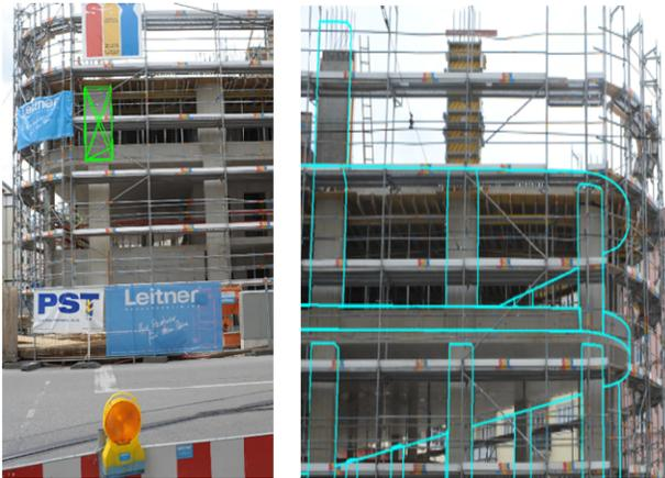
그림 1 4D BIM 및 포인트 클라우드를 활용한 레이블링 생성[10]
